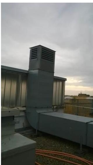
Le circuit de ventilation du secteur chaud est indépendant de l'ensemble du système de ventilation du reste du bâtiment. Le rejet s'effectue sur la terrasse niveau 4 et l'air extrait ne fait pas l'objet d'un recyclage, distant de toutes prises d'air neuf (Cf photo ci-contre).
