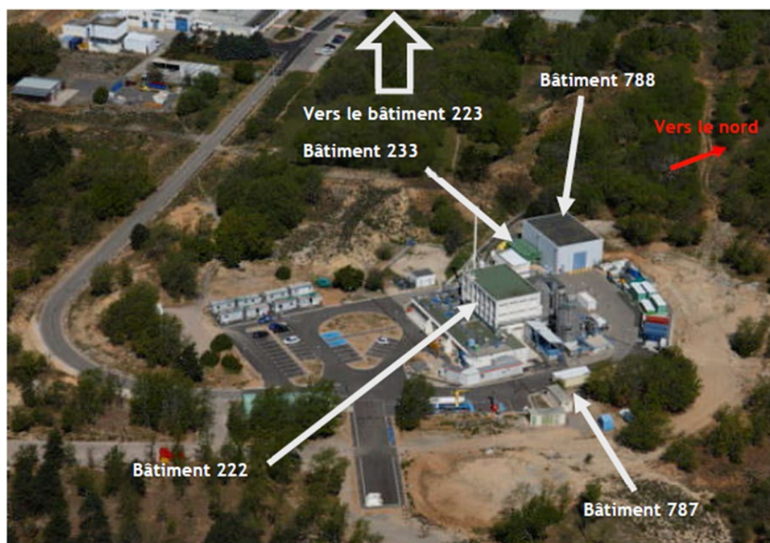
Figure 2 : Bâtiments de l'INB n°24
