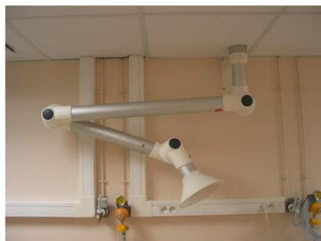
**Figure 13 :** le système d'extraction utilisé lors des explorations pulmonaires.
